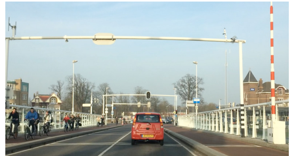
Voorbeeld van een brug met twee oeverkruispunten, meerdere rijbanen en nabij een NS-station (Stadsbrug Kampen, 2014)
