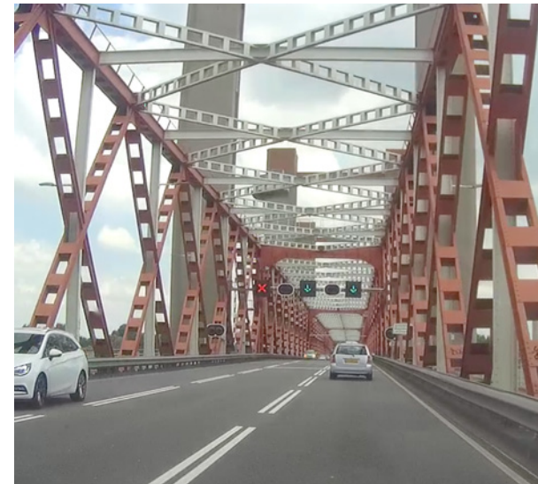
Voorbeeldsituatie van een moeilijk herkenbaarheid van de landverkeersseinen (Spijkensbrug, 2017).
