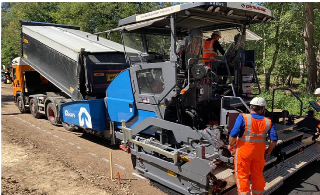
Elektrische asfalt spreidmachine
