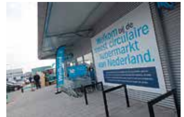
Eerste circulaire supermarkt van Nederland, in Westergouw, Gouda. Betonmortel met 42 procent gerecyclede grondstoffen.
