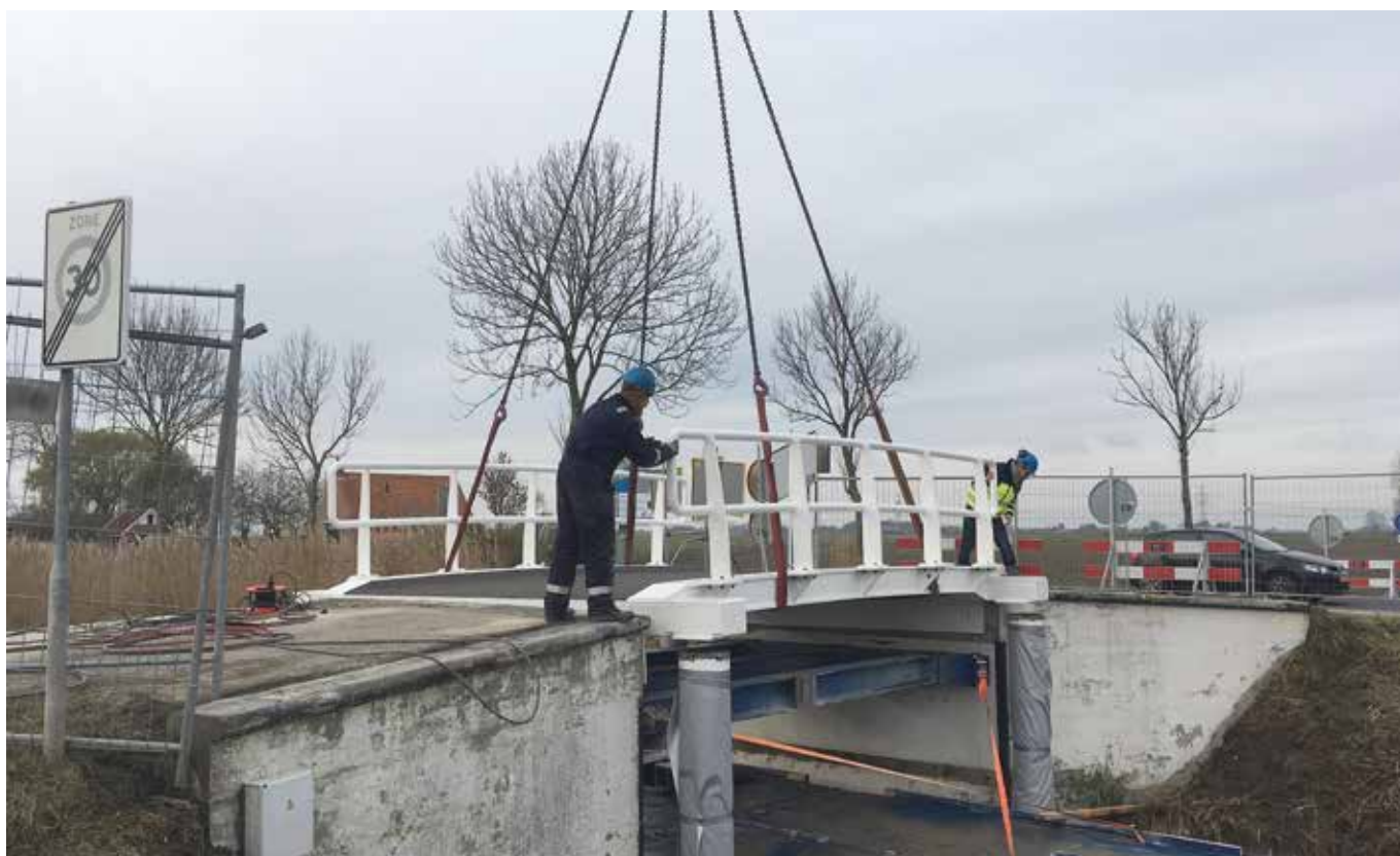
Brug Juistertil als voorbeeld van hergebruik van landhoofden in plaats van de gehele vervanging van de brug.
