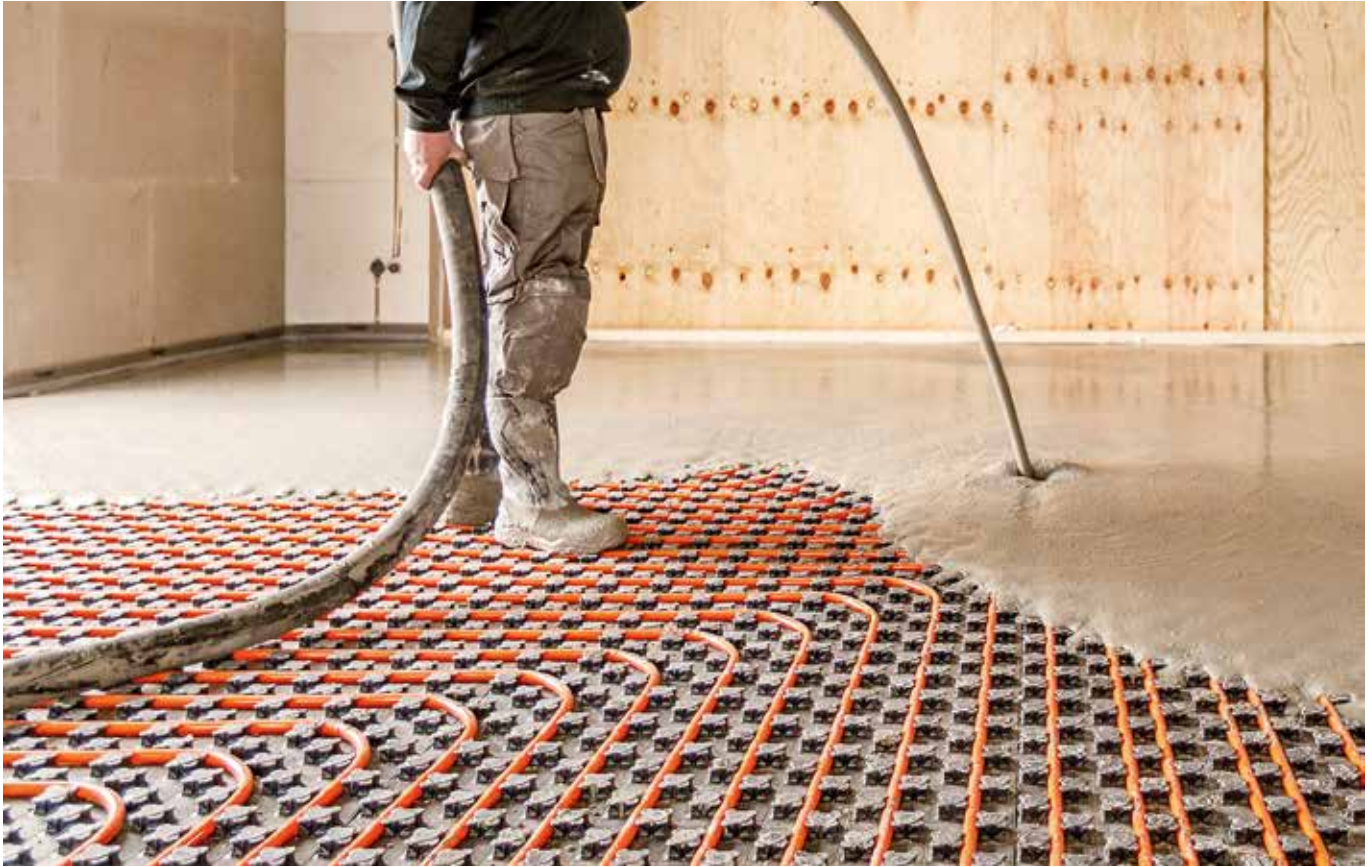
Aanbrengen van Eco2floor, zelfverdichtend, verpompbaar gietvloersysteem op basis van gemalen gegranuleerde hoogovenslak.
