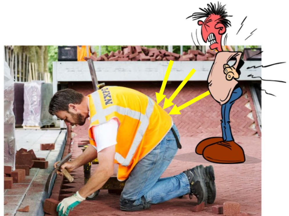
▲ Een stratenmaker werkt de randjes af, terwijl een machine het grootste deel van de stenen legt. © Marlies Wessels / archief
