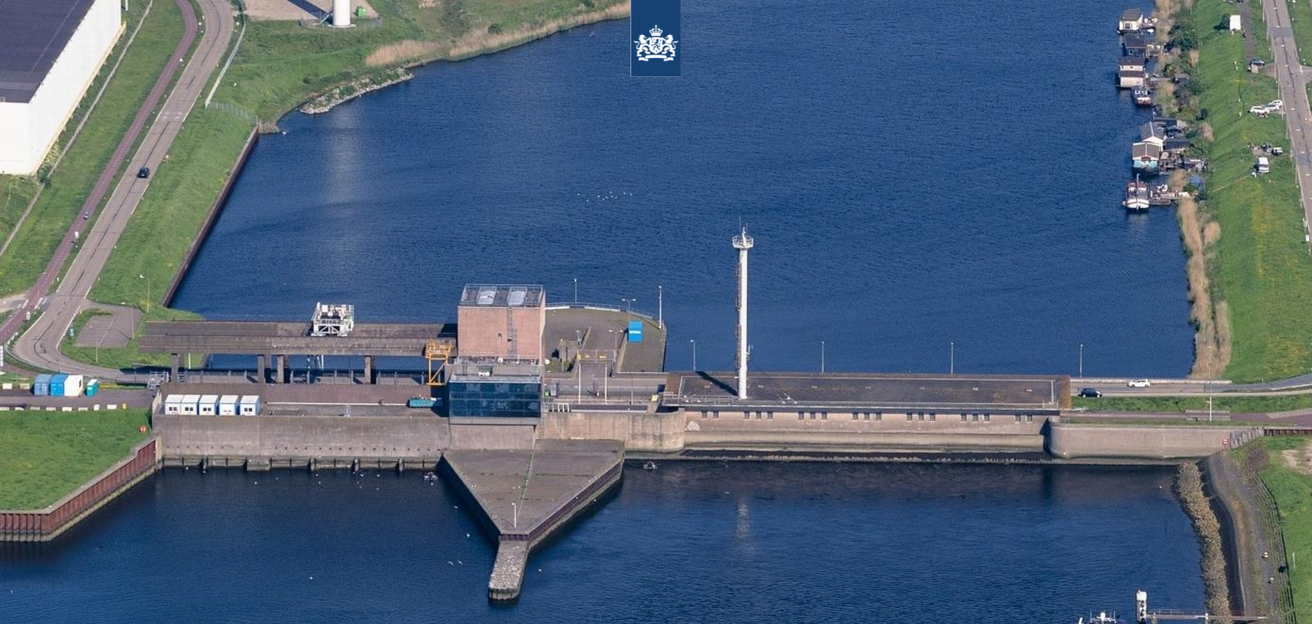
Spui- en Gemaalcomplex IJmuiden
