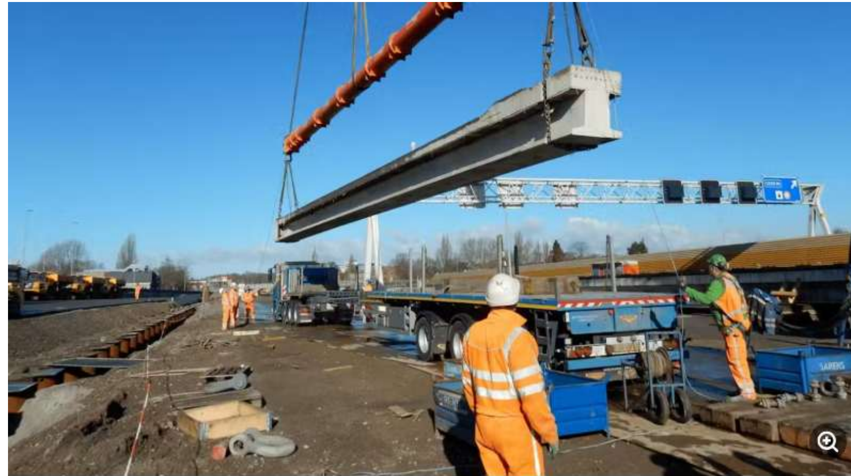
Een van de liggers van een oud viaduct over de A9 wordt 'geogost' voor hergebruik in een viaduct over de A76 Foto: © Nebest
