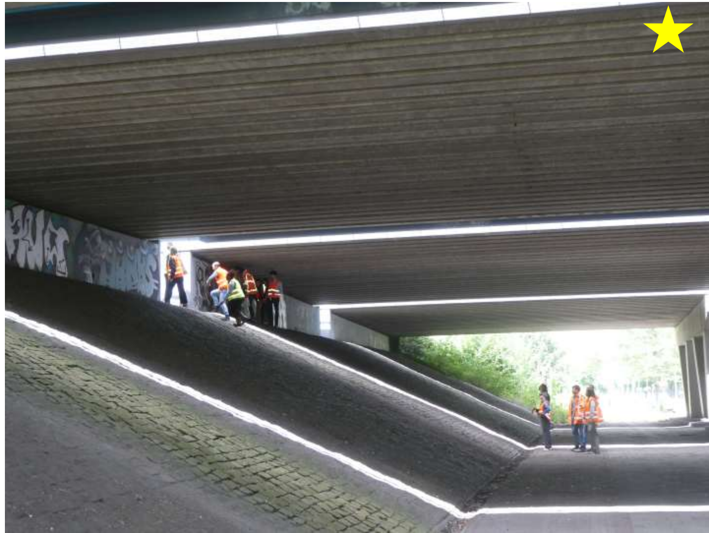
Een van de liggers van een oud viaduct over de A9 wordt 'geogost' voor hergebruik in een viaduct over de A76 Foto: © Nebest
